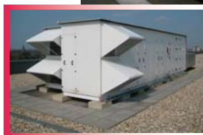
Aanzuig- en afblaaskappen zijn haaks op elkaar gepositioneerd om kortsluiting van lucht te voorkomen
